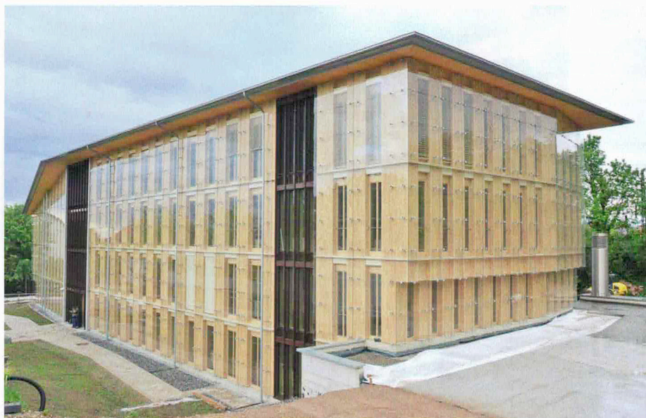
Die Holzfassade am Haus der Bauern in Freiburg ist durch die doppelt geschuppte Glasfassade vor Schlagregen geschützt.
